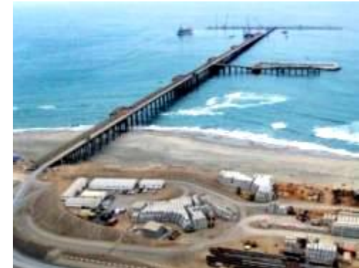
Estudios de maniobra, agitación y aterramiento del canal de acceso a la terminal de carga LNG de Pampa-Melchorita
